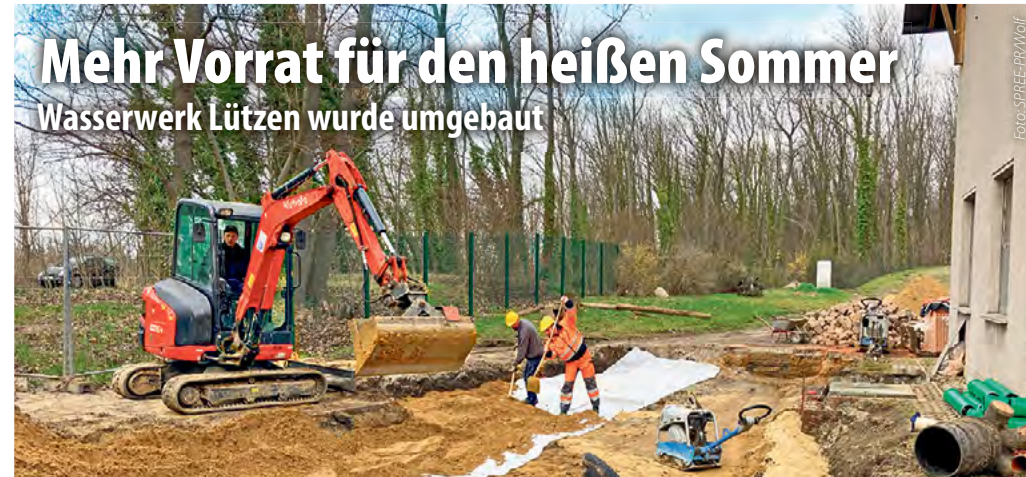
Mehr Vorrat für den heißen Sommer Wasserwerk Lützen wurde umgebaut
