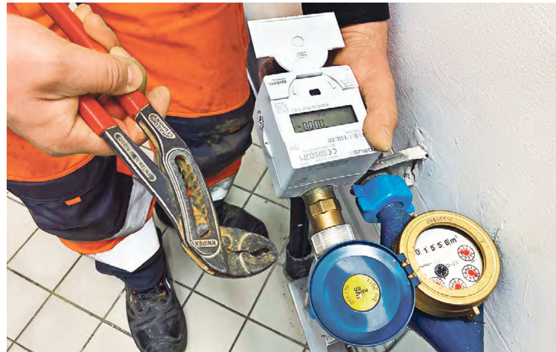
Alt gegen neu: In verschiedenen Orten des Verbandsgebietes werden Funkzähler eingebaut. Fotos (2): SPREE-PR/Wolf
